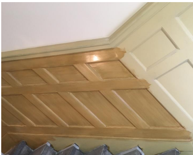
Grundierung Venti Alkydharz, Grundierung Öl-Lasur pigmentiert
