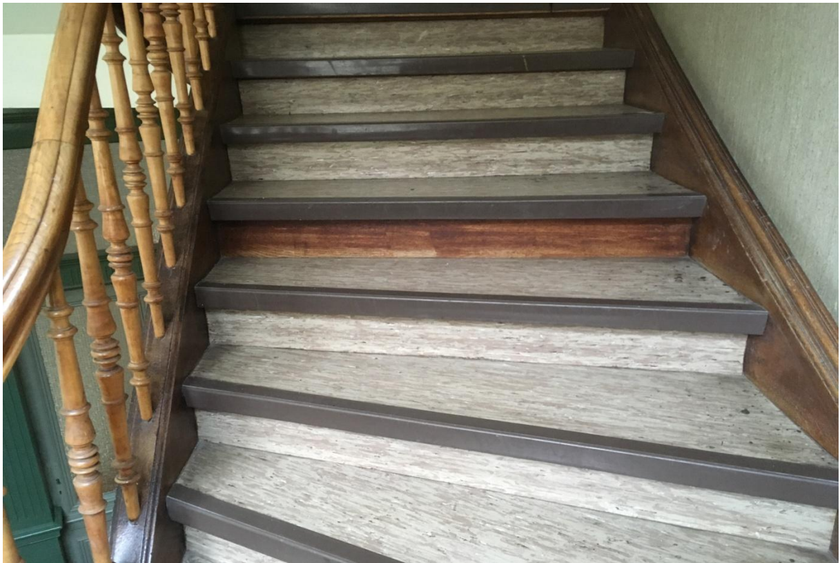
Stufen ( Etagen 1-3 )wurden an Kanten abgesägt und mit PVC beklebt, Podeste sind ebenfalls mit PVC beklebt – was ist darunter? -- vermutlich Parkett
