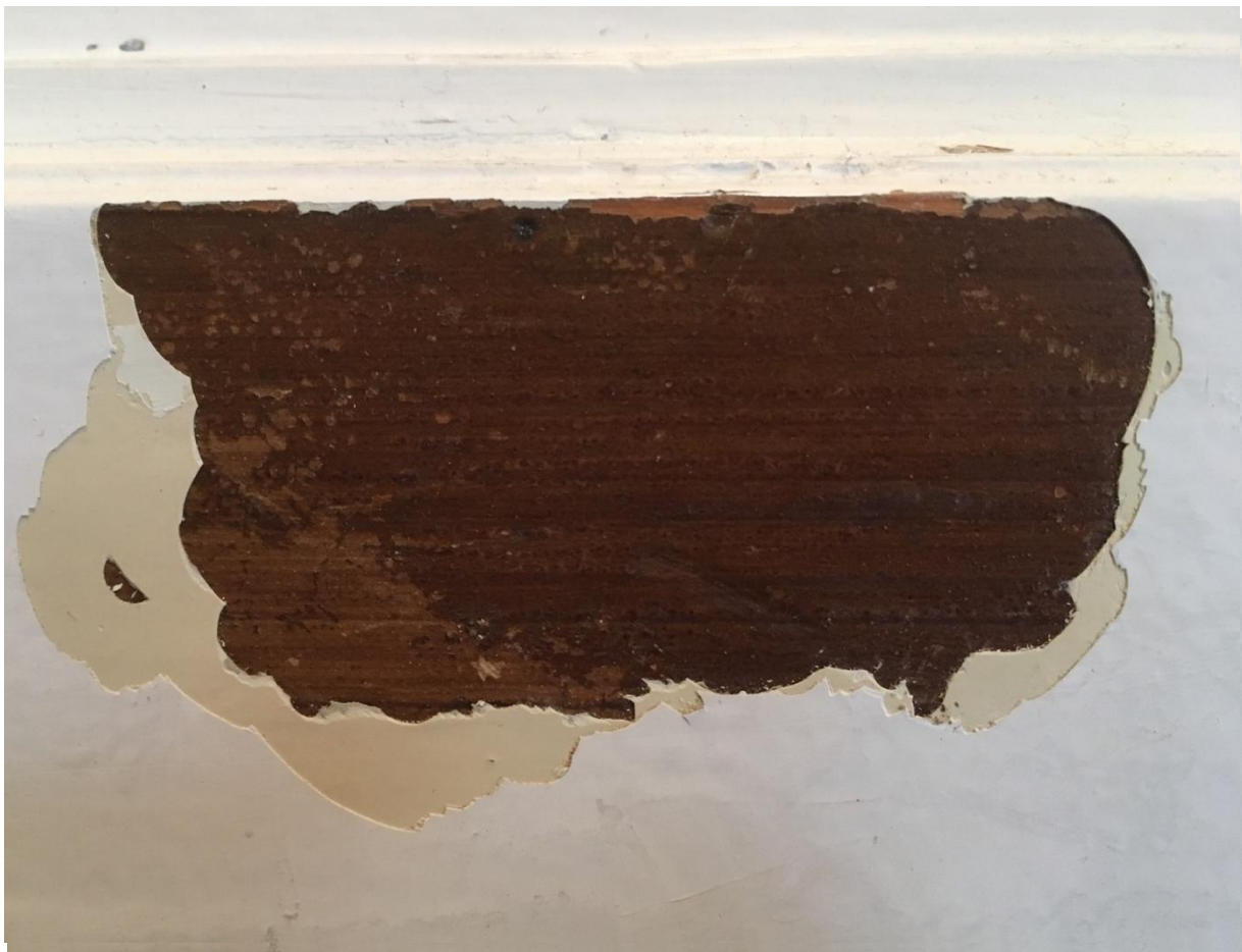
Innenseite vergrößert, Maserierung ist im Laufe der Jahrzehnte stark nachgedunkelt -- war zur Bauzeit heller
