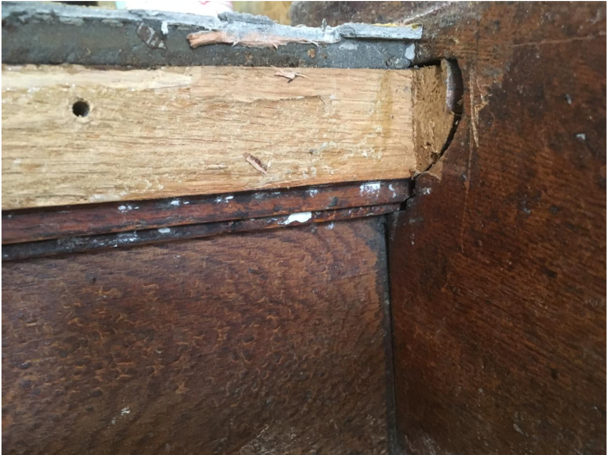
Vorbereitung zum Anbringen der neuen „Originalkanten“
