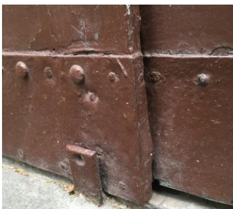
Zustand vor der Restaurierung: Türe klemmt an allen Ecken und Enden, Schloß schließt nicht
