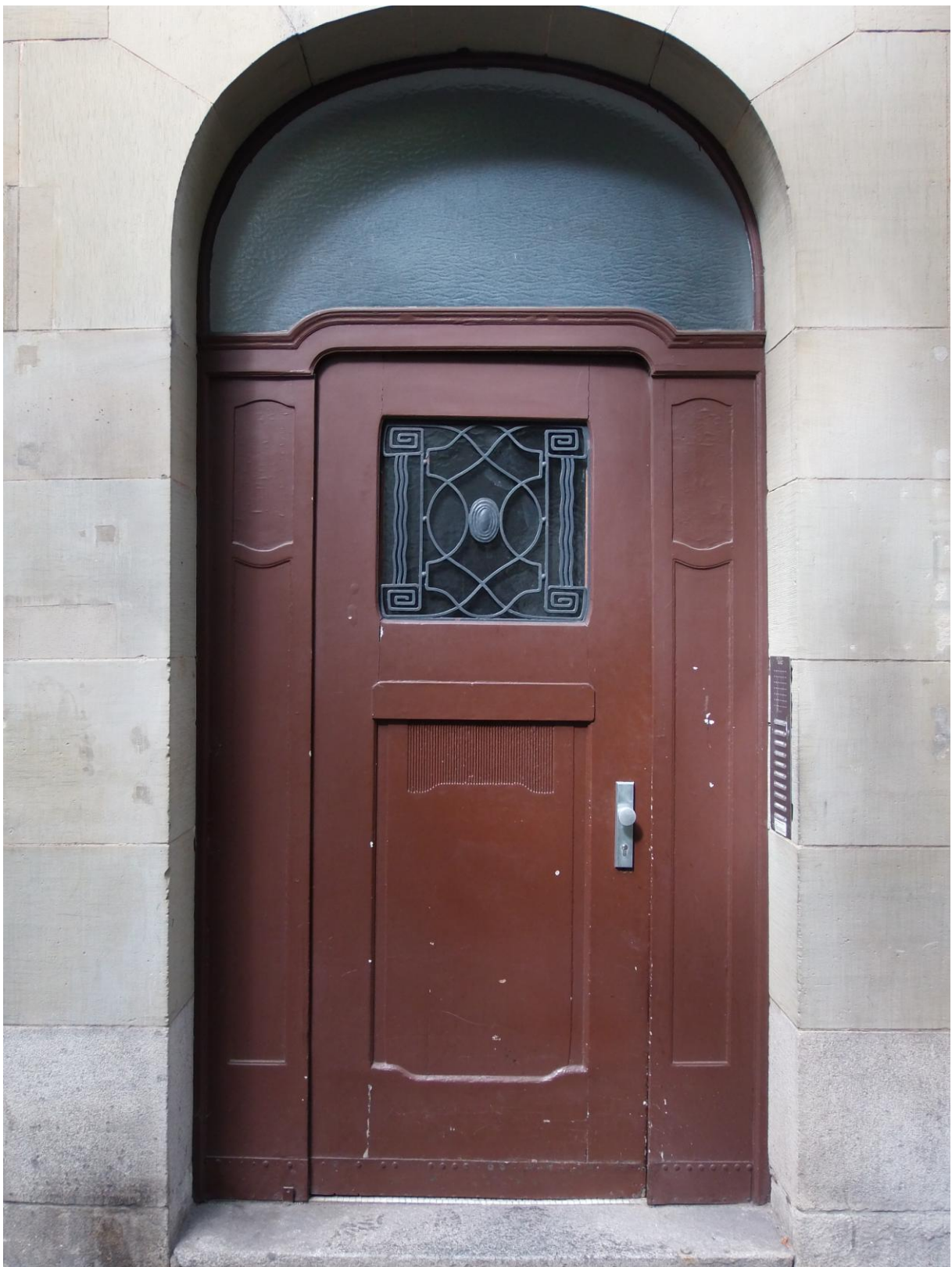
Zustand vor der Restaurierung: Türe klemmt an allen Ecken und Enden, Schloß schließt nicht
