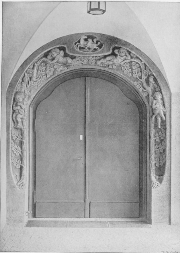
Sammelschule an der Heusteigstraße in Stuttgart. Portal.
