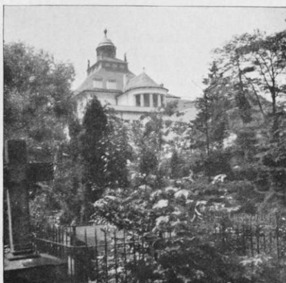
Sammelschule an der Heusteigstraße in Stuttgart.
