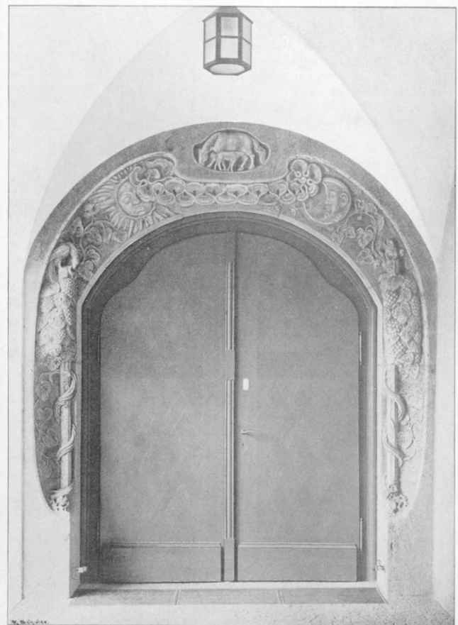
Sammelschule an der Heusteigstraße in Stuttgart. Portal.
