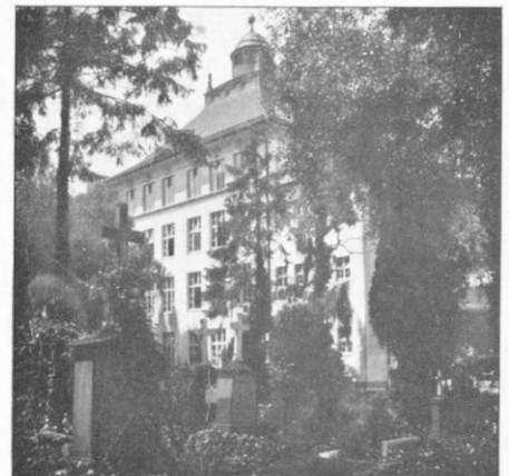
Sammelschule an der Heusteigstraße in Stuttgart.
