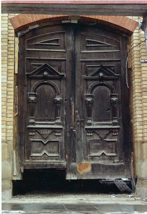
Tür im Originalzustand mit Holzprobe.
