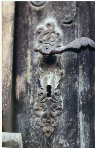
Türdrücker und Schließblech im Originalzustand.
